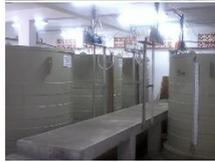
Fluoretação e Neutralização: o flúor é adicionado para auxiliar na prevenção da cárie e alcalinizante para neutralizar a acidez da água.
