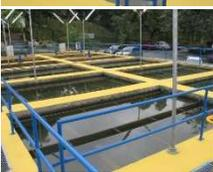
Decantação: por serem mais pesados, os flocos oriundos do floculador se depositam no fundo do decantador. A água limpa fica na parte superior e segue no tratamento.
